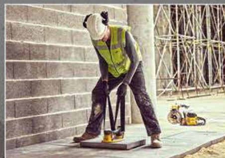
Dalles de béton et carrelage
