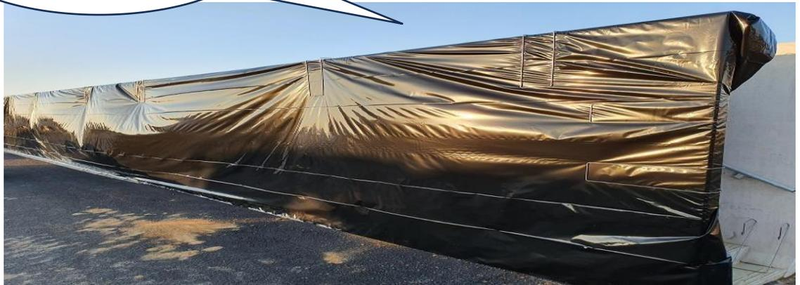
SILOSIDE COVER® est un film d'ensilage spécialement conçu pour la couverture des murs des silos. Le film est très résistant : il permet une parfaite protection du mur contre les agressions acides de l'ensilage tout en assurant une parfaite conservation de ce dernier. Les tailles adaptées permettent un positionnement facile et rapide en amont du chantier d'ensilage.
